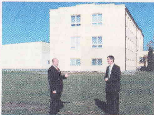
■ Modernizacja szkoły w Makowcu i wykonanie nowej elewacji były priorytetami wśród tegorocznych inwestycji oświatowych - mówi Henryk Słomka, zastępca burmistrza Skaryszewa, (na zdjęciu z lewej), obok dyrektor szkoły w Makowcu.
